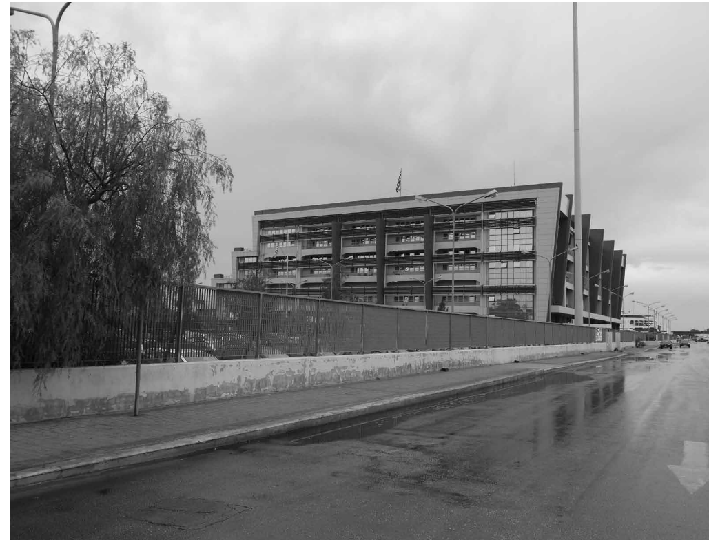
Bâtiment du siège national des gardes-côtes grecs au Pirée, octobre 2013
